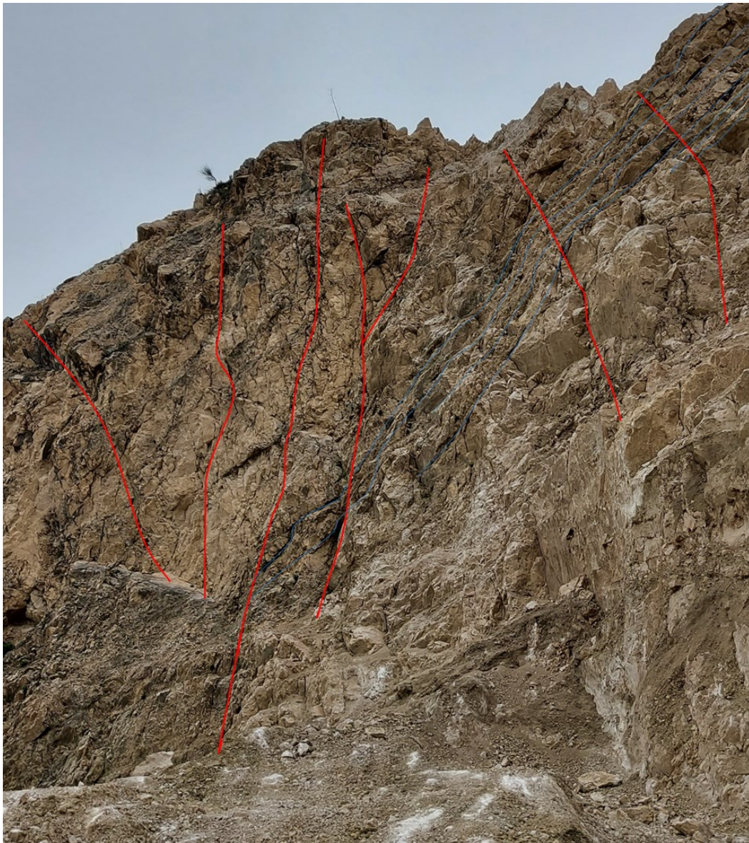
Foto n. 4 – Fascia cataclasata sulla parete occidentale a confine con le proprietà CECA - SEMAC, con strati a franapoggio visibili sul fronte della cava: la geometria del fronte e le caratteristiche strutturali dell'ammasso sono state derivate da rilievi di dettaglio operati in sito. In particolare, nel modello sono stati riprodotti due sets principali di discontinuità, quello subparallelo al fronte della cava e quello costituito dai giunti di stratificazione sub-orizzontali con giacitura a franapoggio. Inoltre, è stata altresì introdotta nel modello una direttrice di faglie sub-verticali, ubicate a pochi metri dal ciglio del front
