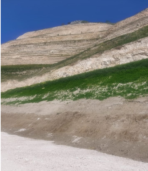
Foto n. 5 – 6 - 7 - Microgradoni realizzati nei primi 9/10 anni di attività del Consorzio: il nuovo profilo del versante presenta pendenze inferiori ai 45°, pendenza pienamente compatibile con le caratteristiche geotecniche e strutturali del fronte di cava, con coefficiente di sicurezza abbondantemente superiore all'unità, anche in fase sismica ( FC = 2,063 (2,277) - 1,247 (1,359) – 1,305 (1,447)).
