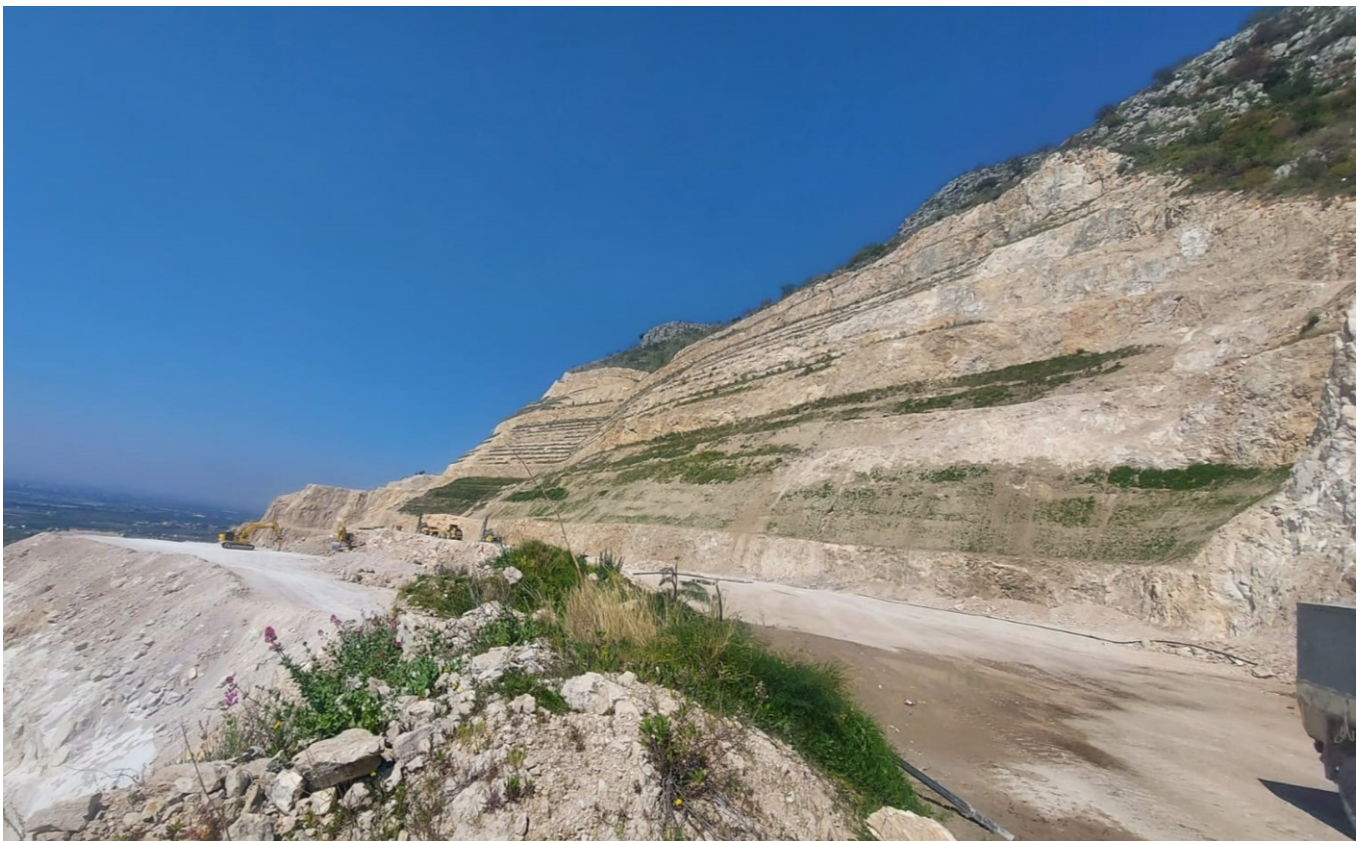
Foto n. 5 – 6 - 7 - Microgradoni realizzati nei primi 9/10 anni di attività del Consorzio: il nuovo profilo del versante presenta pendenze inferiori ai 45°, pendenza pienamente compatibile con le caratteristiche geotecniche e strutturali del fronte di cava, con coefficiente di sicurezza abbondantemente superiore all'unità, anche in fase sismica ( FC = 2,063 (2,277) - 1,247 (1,359) – 1,305 (1,447)).
