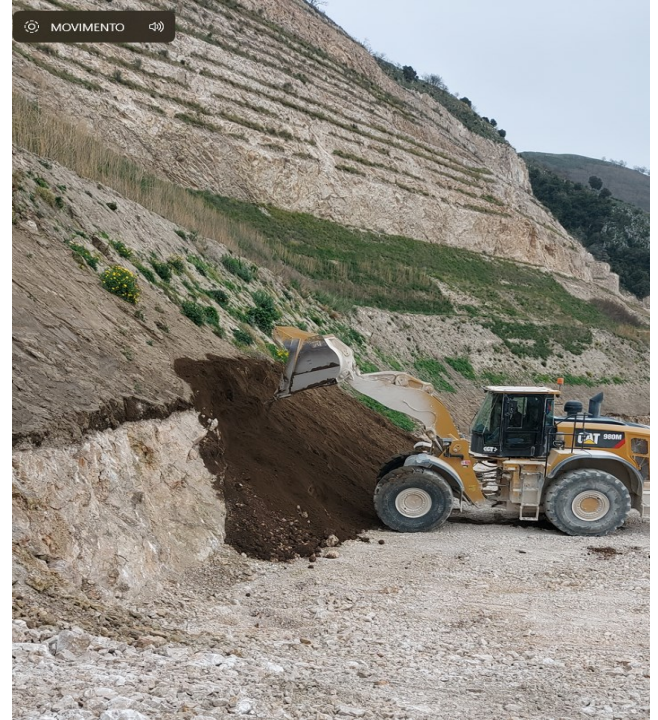
Foto n. 5 – 6 - 7 - Microgradoni realizzati nei primi 9/10 anni di attività del Consorzio: il nuovo profilo del versante presenta pendenze inferiori ai 45°, pendenza pienamente compatibile con le caratteristiche geotecniche e strutturali del fronte di cava, con coefficiente di sicurezza abbondantemente superiore all'unità, anche in fase sismica ( FC = 2,063 (2,277) - 1,247 (1,359) – 1,305 (1,447)).
