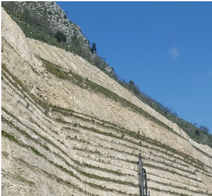
Foto n. 5 – 6 - 7 - Microgradoni realizzati nei primi 9 anni di attività del Consorzio: il nuovo profilo del versante presenta pendenze inferiori ai 45^{\circ}/50^{\circ} , pendenza pienamente compatibile con le caratteristiche geotecniche e strutturali del fronte di cava, con coefficiente di sicurezza abbondantemente superiore all'unità, anche in fase sismica ( FC = 1,43 - 1,50 - 2,83 ).
