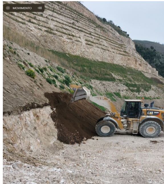
Foto n. 5 – 6 - 7 - Microgradoni realizzati nei primi 9 anni di attività del Consorzio: il nuovo profilo del versante presenta pendenze inferiori ai 45^{\circ}/50^{\circ} , pendenza pienamente compatibile con le caratteristiche geotecniche e strutturali del fronte di cava, con coefficiente di sicurezza abbondantemente superiore all'unità, anche in fase sismica ( FC = 1,43 - 1,50 - 2,83 ).
