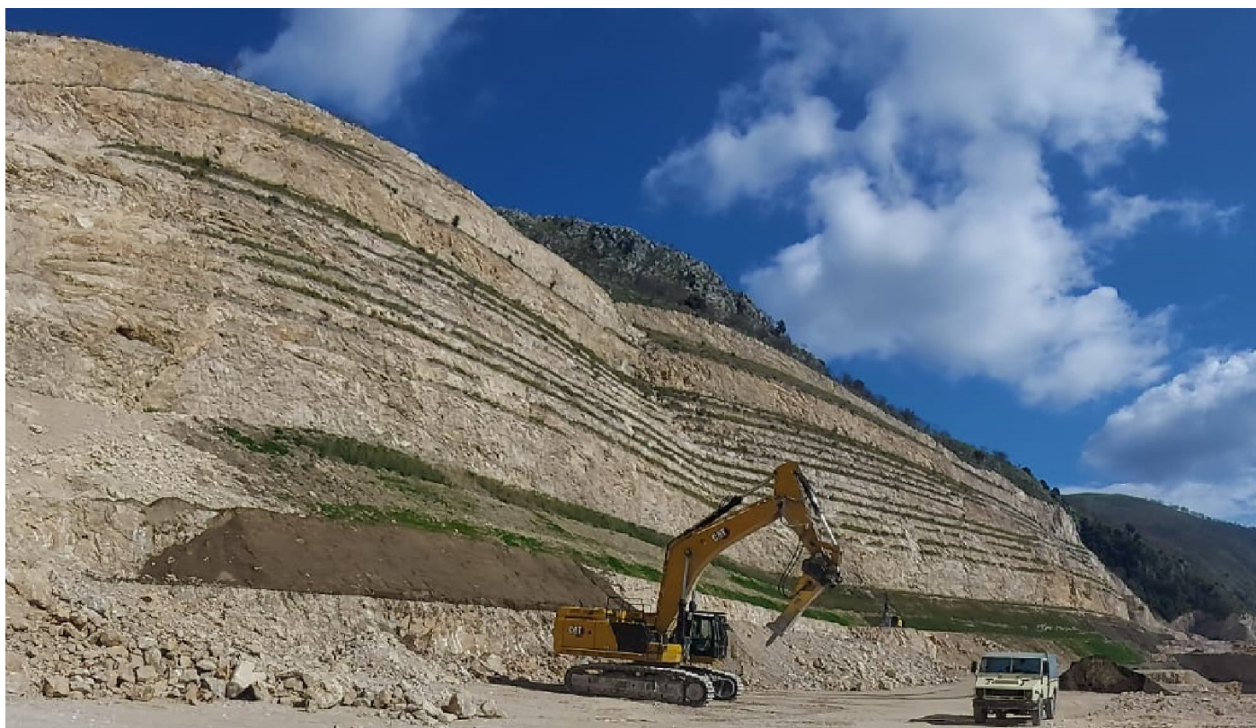
Foto n. 5 – 6 - 7 - Microgradoni realizzati nei primi 9 anni di attività del Consorzio: il nuovo profilo del versante presenta pendenze inferiori ai 45^{\circ}/50^{\circ} , pendenza pienamente compatibile con le caratteristiche geotecniche e strutturali del fronte di cava, con coefficiente di sicurezza abbondantemente superiore all'unità, anche in fase sismica ( FC = 1,43 - 1,50 - 2,83 ).
